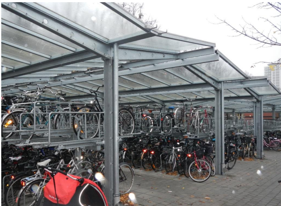
Figur 5-24 Tvåvåningsställ med tak vid station Triangeln i Malmö. Cykelställen är av modell Doppelstock-parker, tvåvånings från Orion.
