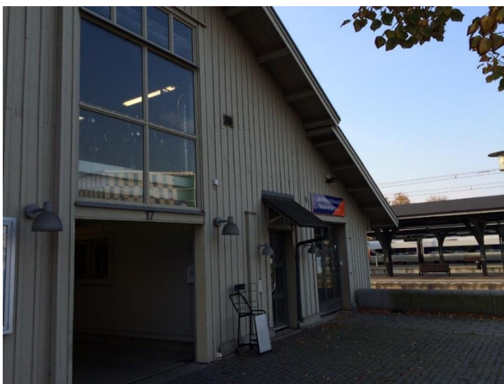
Figur 5-13 På östra sidan finns cykelgaraget Godsmagasinet och en ledränna.
